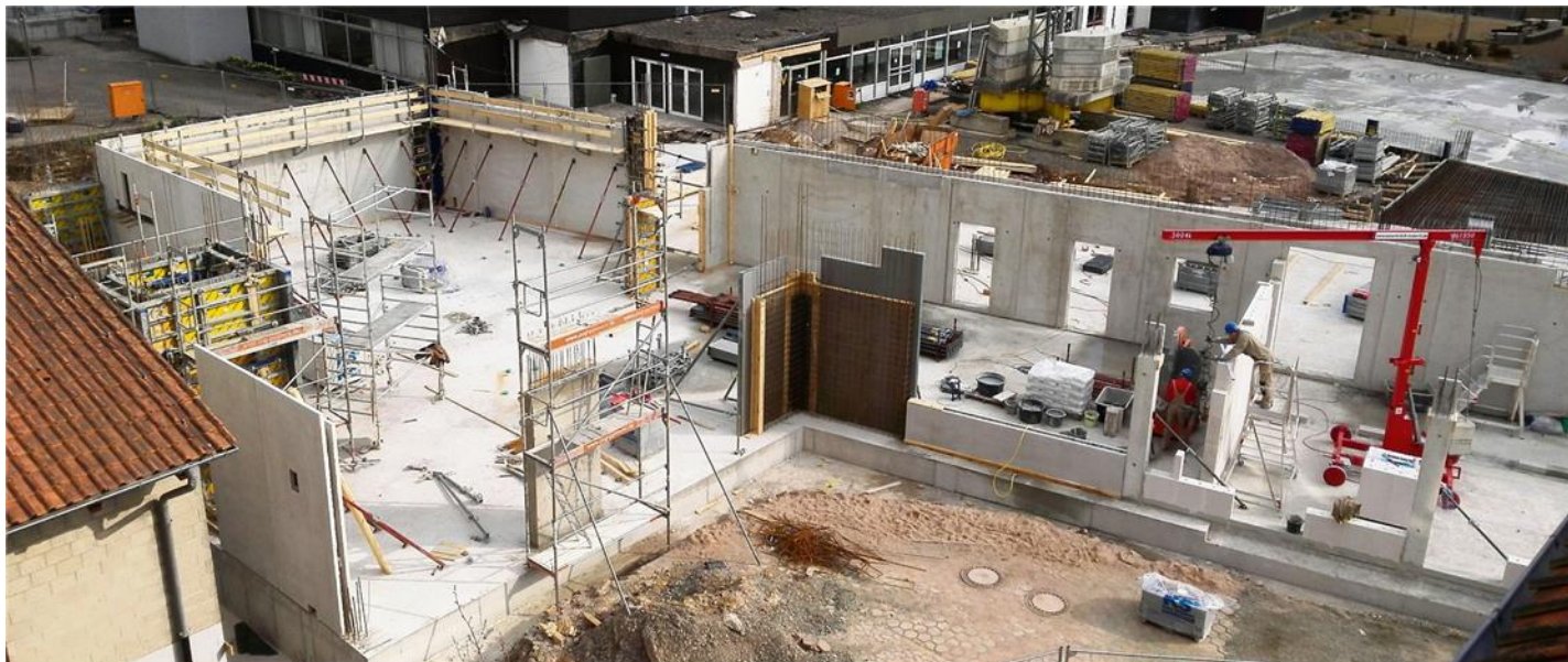
Langsam wächst der Rohbau für das Humboldt-Gymnasium in die Höhe. Das Foto vom Donnerstagnachmittag stammt vom Medienteam „Rembrandt Flights“, das die Baustelle mit drei Webcams beobachtet. Zu finden ist die Bilddokumentation über die Homepage der Stadt Bad Pyrmont.
