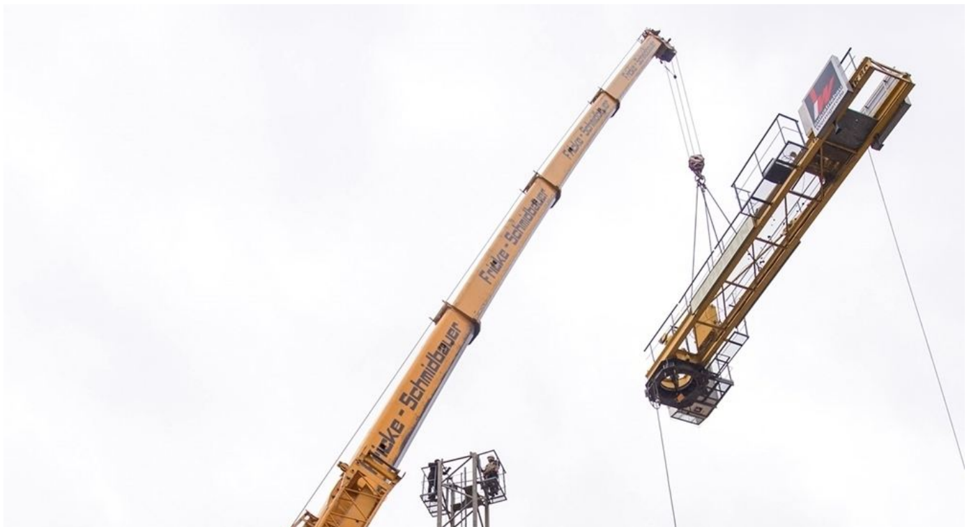
Der Ausleger des Krans wird in luftiger Höhe montiert. Foto: yt
